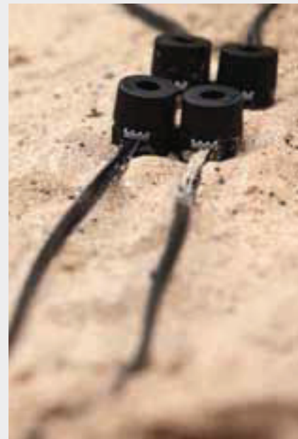
Gebruik meerdere kabelverbinders bij meer dan 50 watt verlichting op de aftakking
